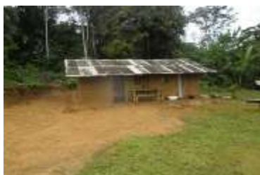
Photo 4 : Vue d'un Logement d'astreinte à l'école publique de Nkoambe
