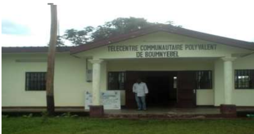
Photo N°8 : Infrastructure de Télécommunication de BOUMNYEBEL
