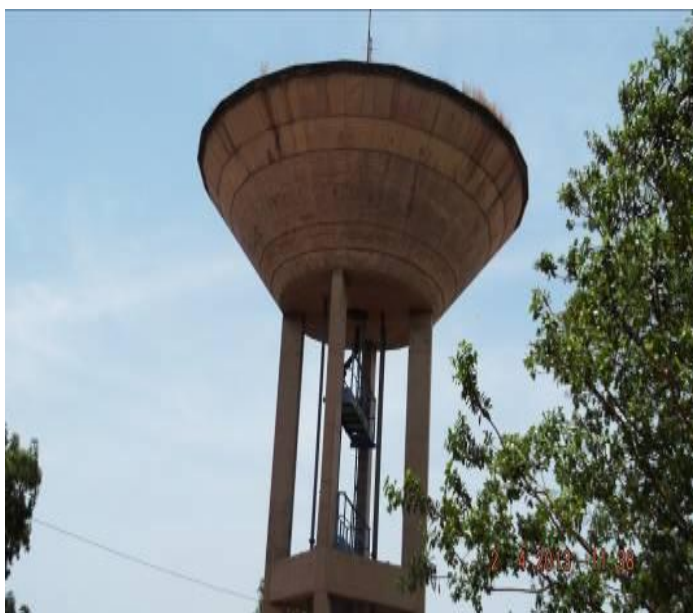
Photo 11 : une borne fontaine à réhabiliter à Mbé (AJLC 2013)
