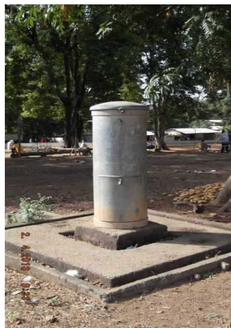
Photo 12 : Le château d'eau de Mbé (AJLC° 2013)
