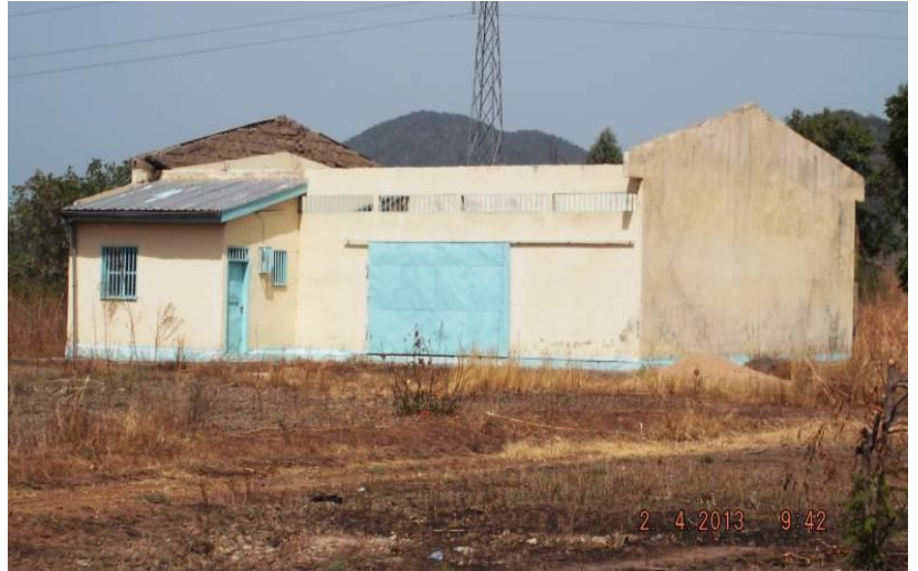
Photo 17 : Magasin de stockage à réhabiliter à Mbé Construit dans le quartier Marouaré à Mbé (AJLC 2013)
