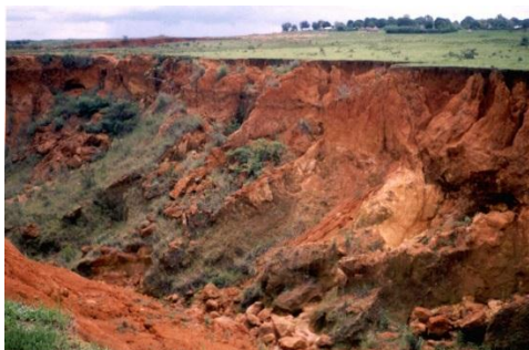
Photo 12. L'érosion régressive menaçant le village FADA Cliché M. Tchotsoua ; Avril 2013
