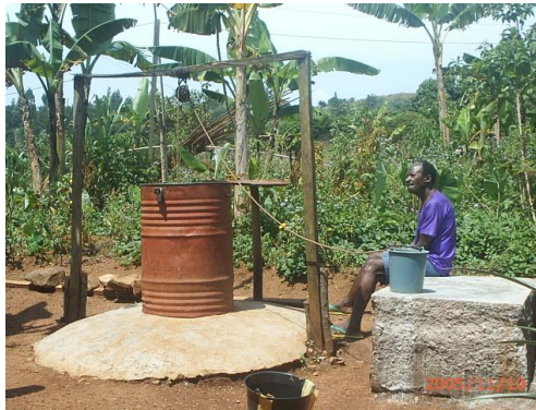
Photo 18 : puits privé équipé de treuil
