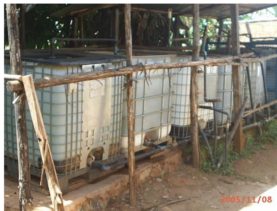
Photo 2 : Les réservoirs du GIC
