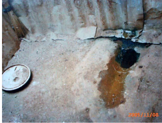
Photo 25 : Fosse couverte en béton armé non lissé.
