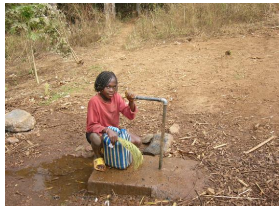
Photo 5 : Borne fontaine réseau Keleng
