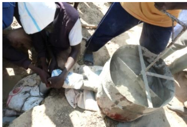
Figure 16. Injections artisanales de mortier à ciment dans une cavité de renard du barrage de Maga.
