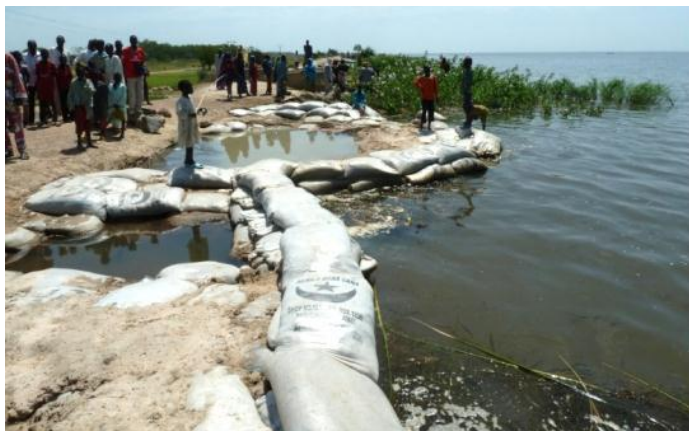
Figure 15. Réparations provisoires u barrage de Maga, avec des sacs de sable.
